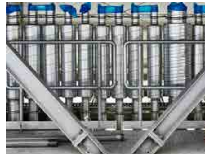
Facility 2025: Die neue Produktionsstätte des DIZG
